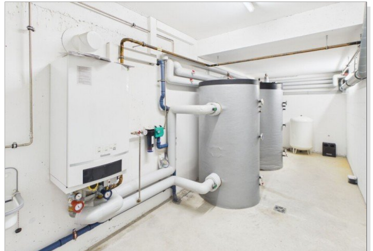
Heizsystem (Wärmepumpe & Gas)
